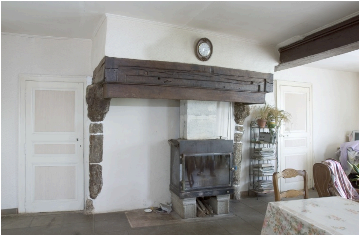
Intérieur du logis, corps principal : la cheminée sur mur-gouttereau.
