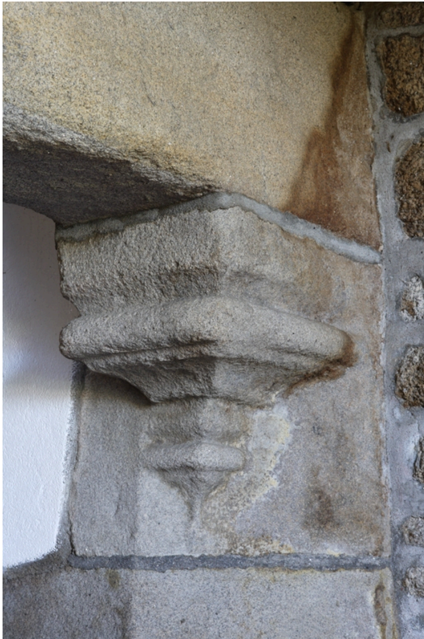
Vieux logis. Rez-de-chaussée. Salle nord. Détail de la console de droite de la cheminée.
