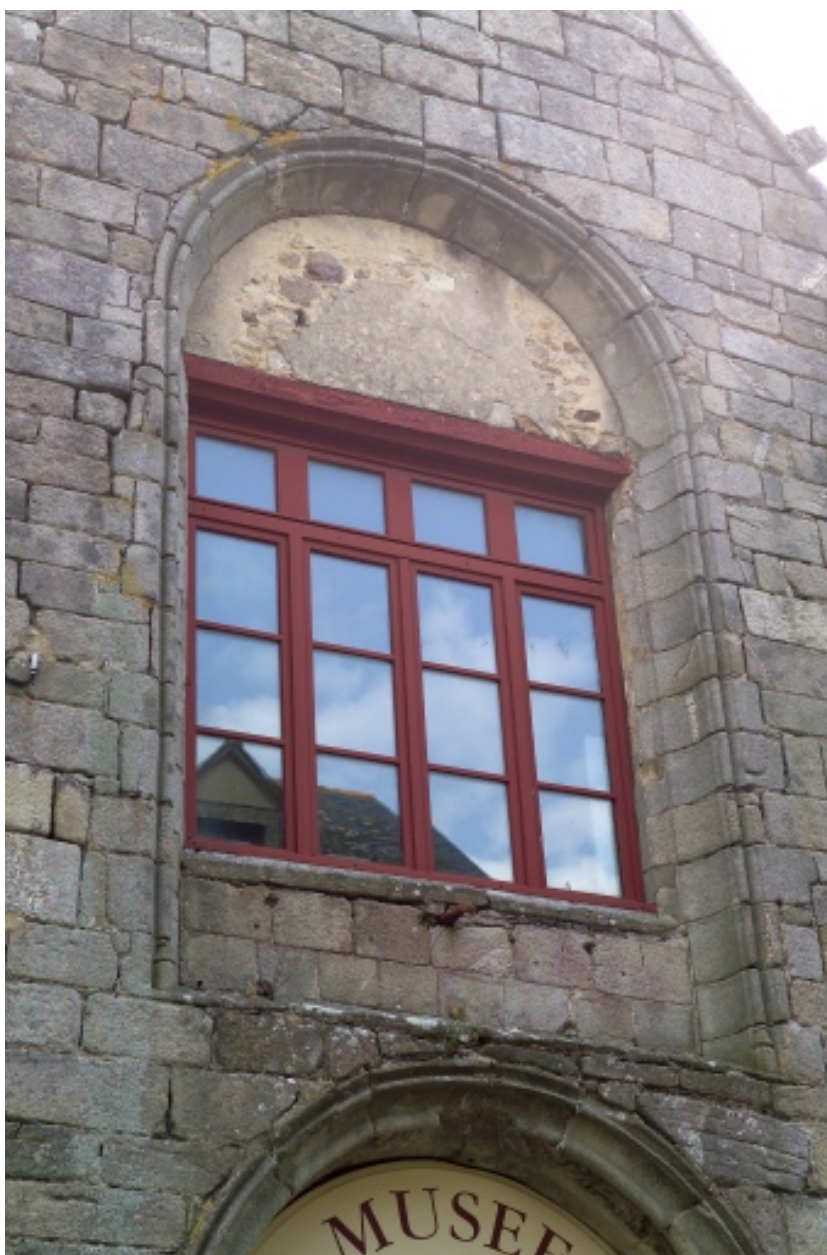
Façade est, détail de la fenêtre.
