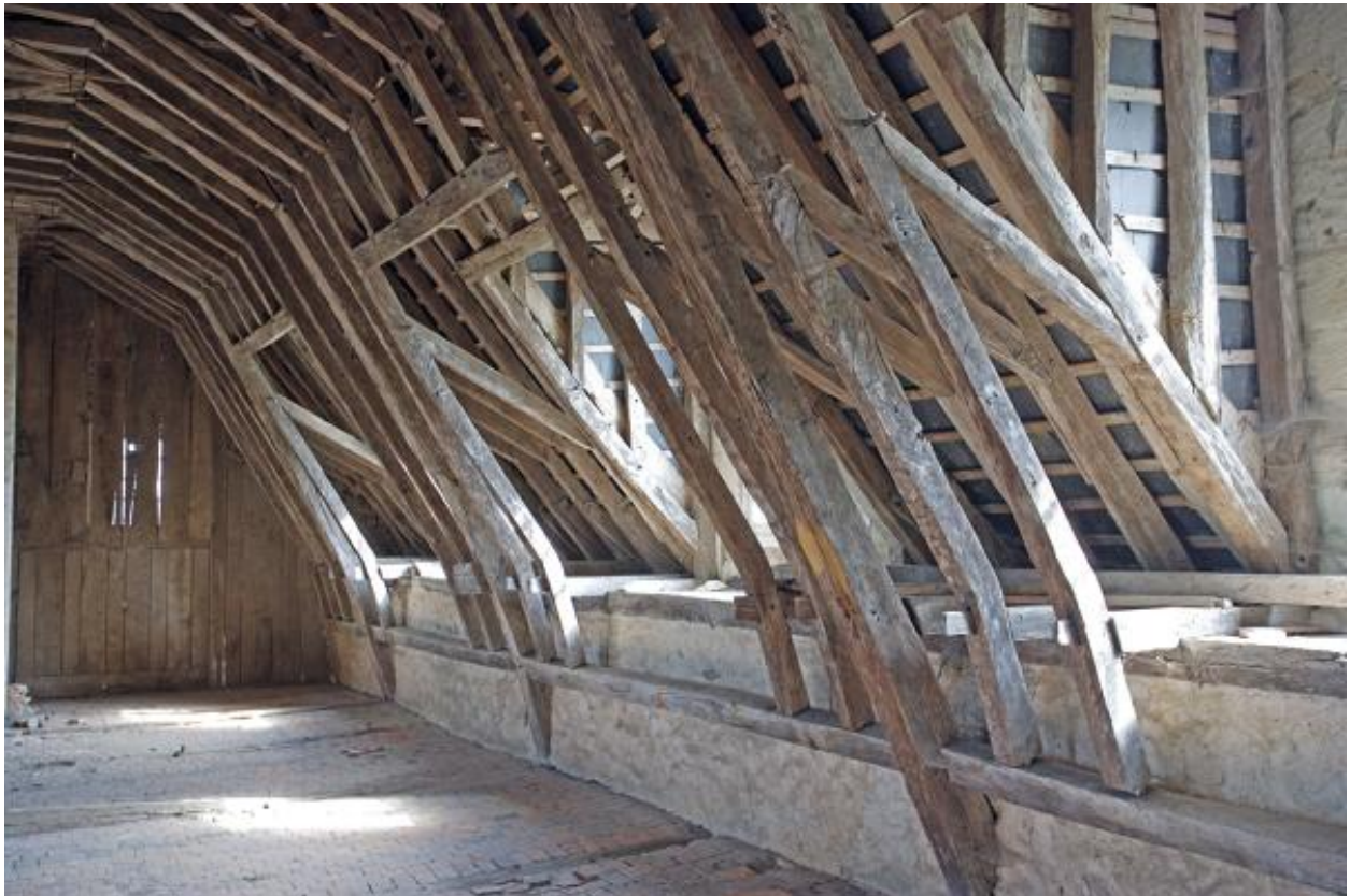
Le grand comble et sa charpente, chevrons, arbalétriers et blochets.
