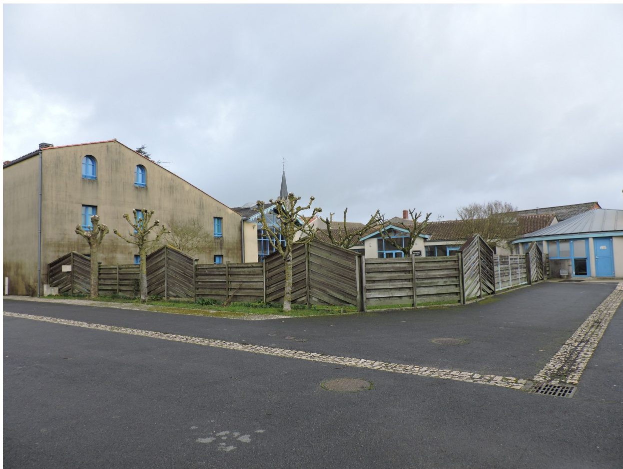
Bâtiments et cantine scolaire vus depuis le sud-ouest.
