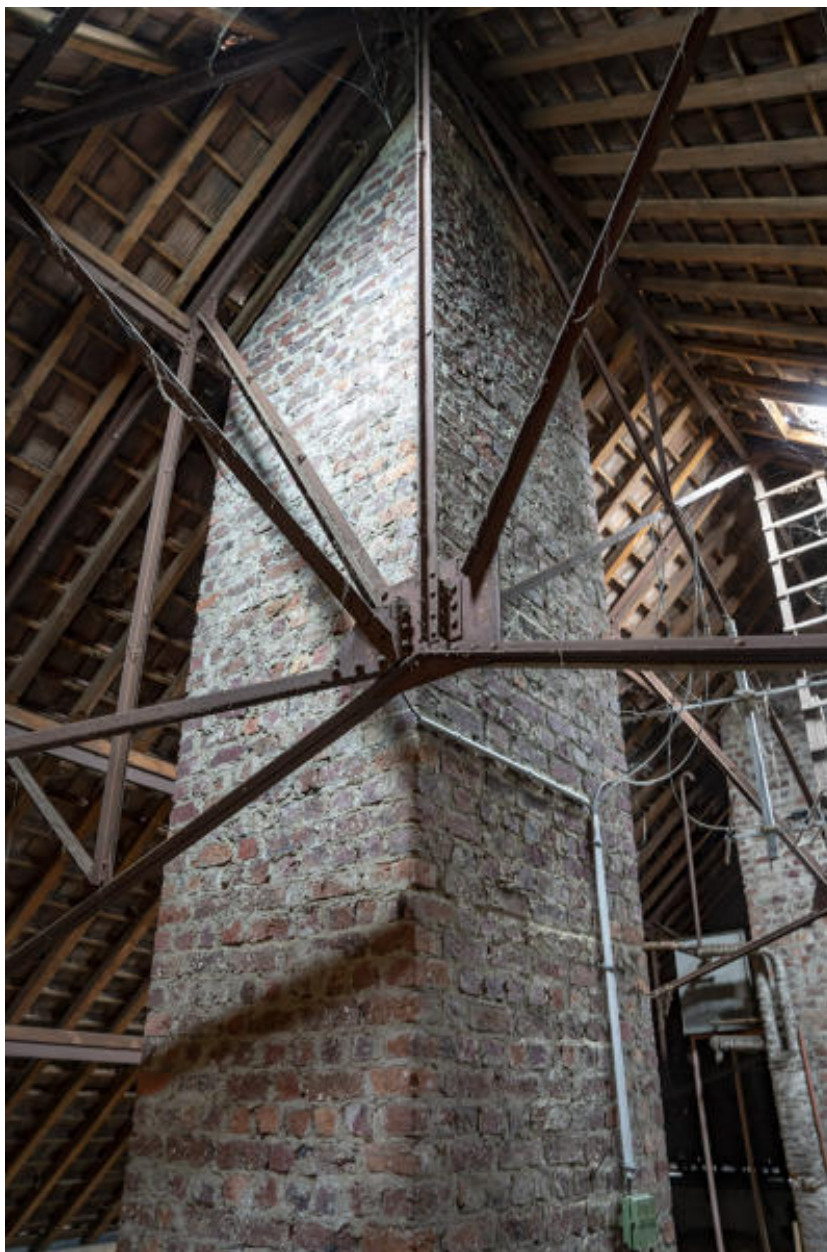
Vue de la charpente métallique.
