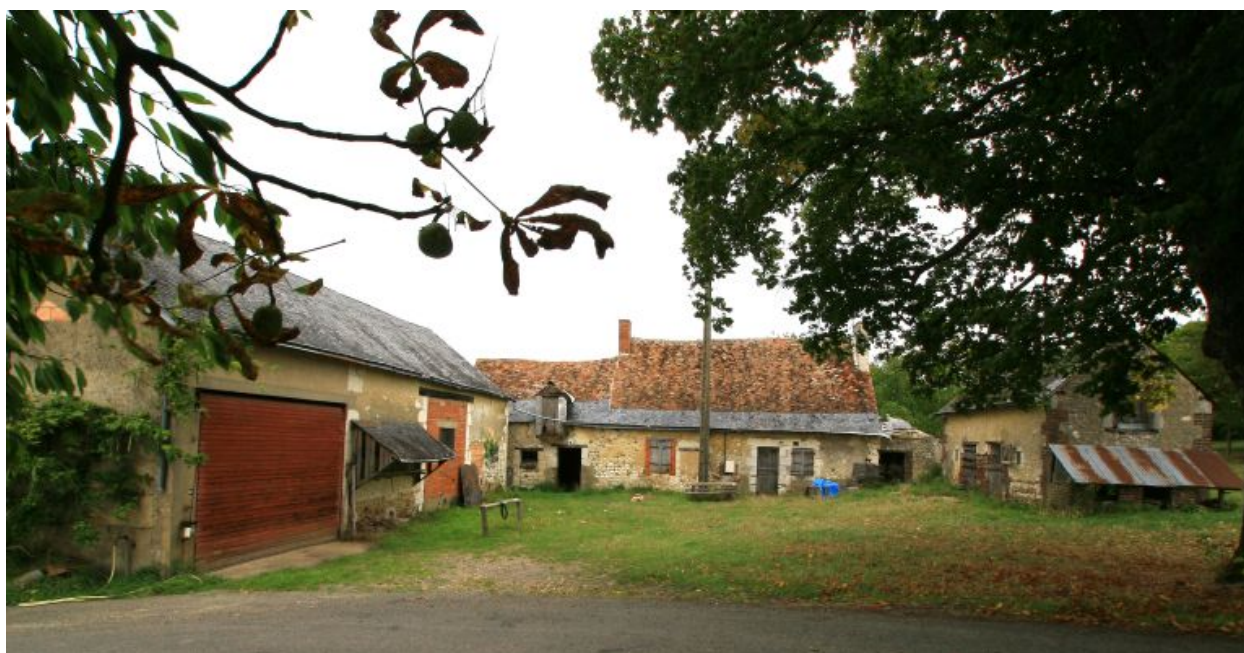
Vue d'ensemble prise depuis la route.
