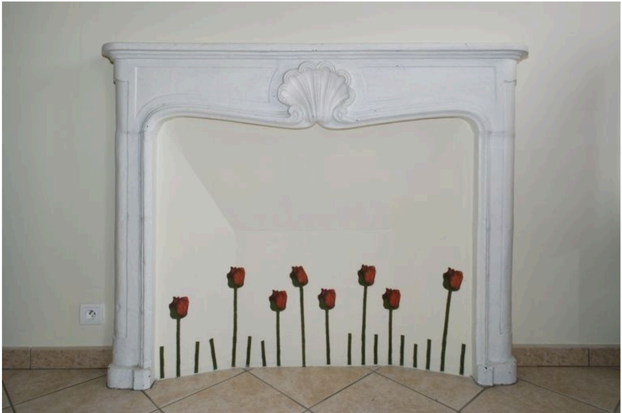
Cheminée de l'une des pièces sur rue, au premier étage.
