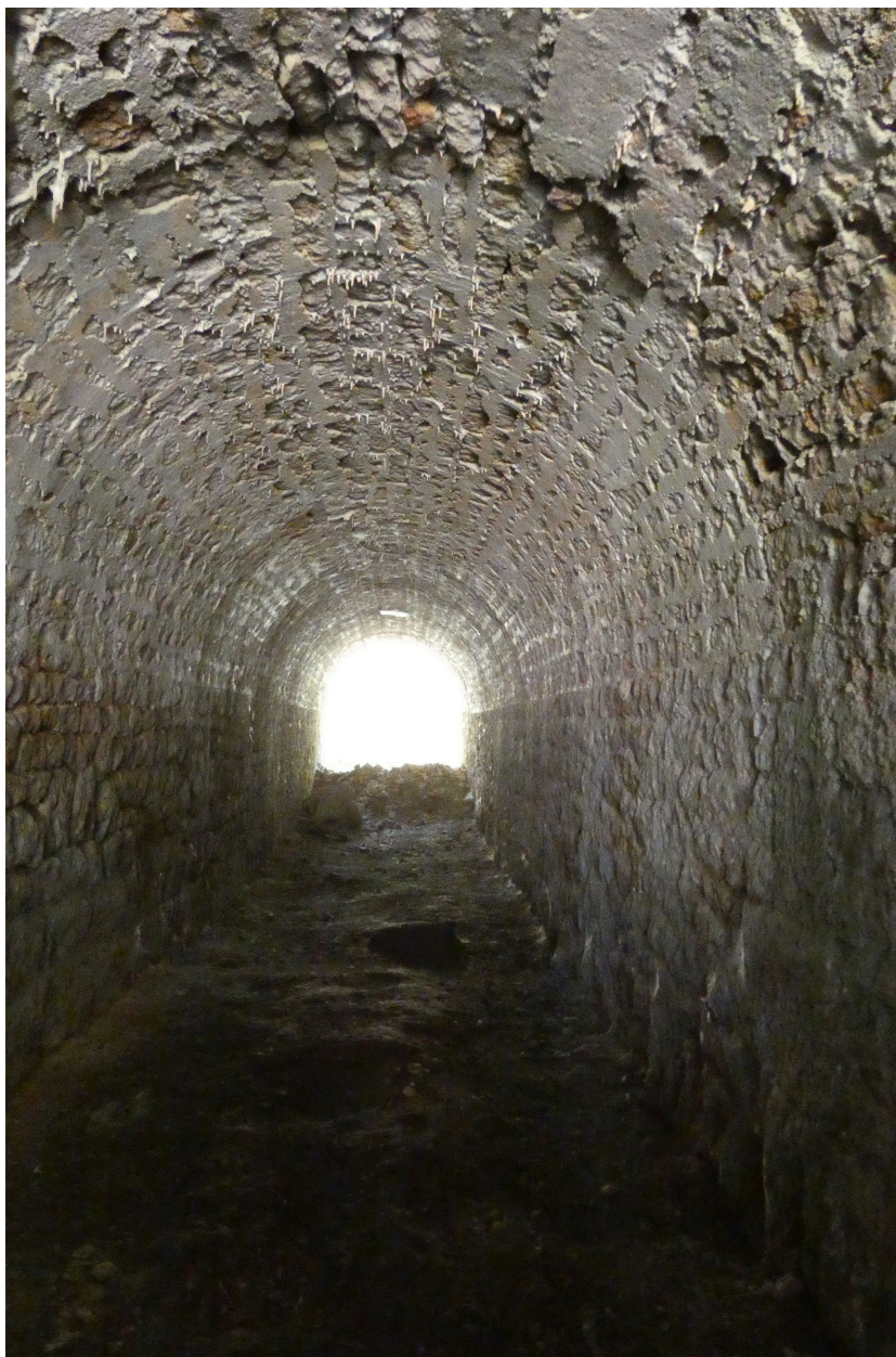
Tunnel voûté reliant les deux carrières.
