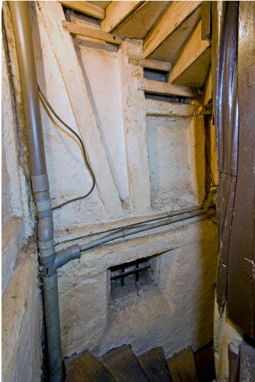
Mur arrière, angle postérieur gauche : cage de l'escalier en vis moulurée entre 1er et 2e étages avec passage du mur de schiste au pan de bois, et fenêtre condamnée par la tour d'escalier en vis de la maison voisine au n° 57, rue Beaurepaire.
