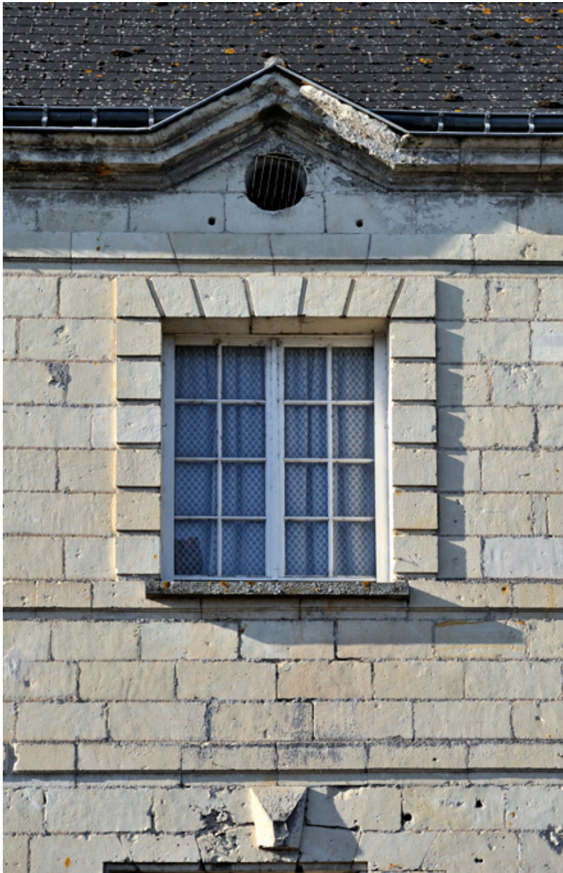
Bais de la travée de l'aile ouest : fenêtre de l'étage et oculus du surcroît.
