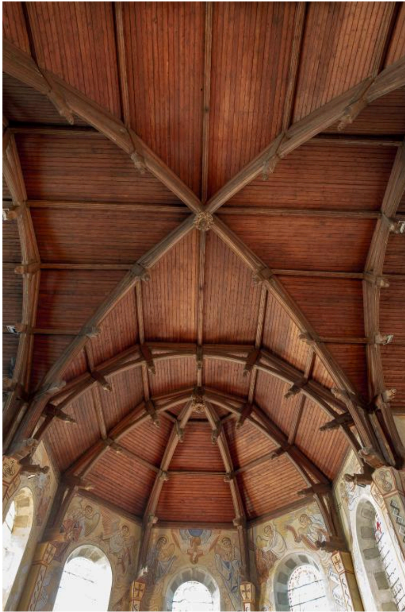
Vue de la voûte de la croisée du transept et du choeur depuis la croisée du transept.
