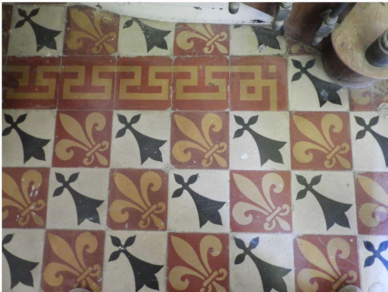
Le pavement dans l'ancienne entrée de la maison.
