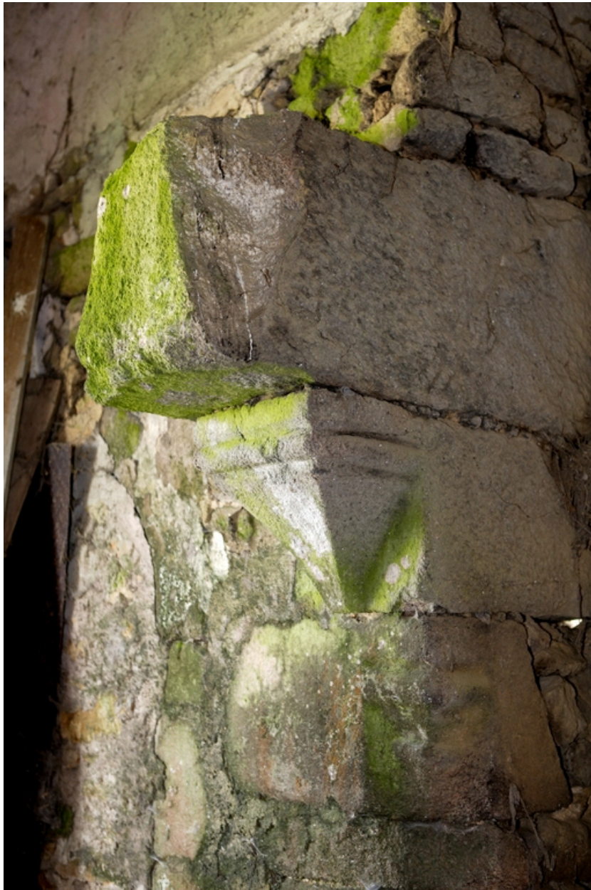
Détail du corbeau gauche de la cheminée du 1er logis.
