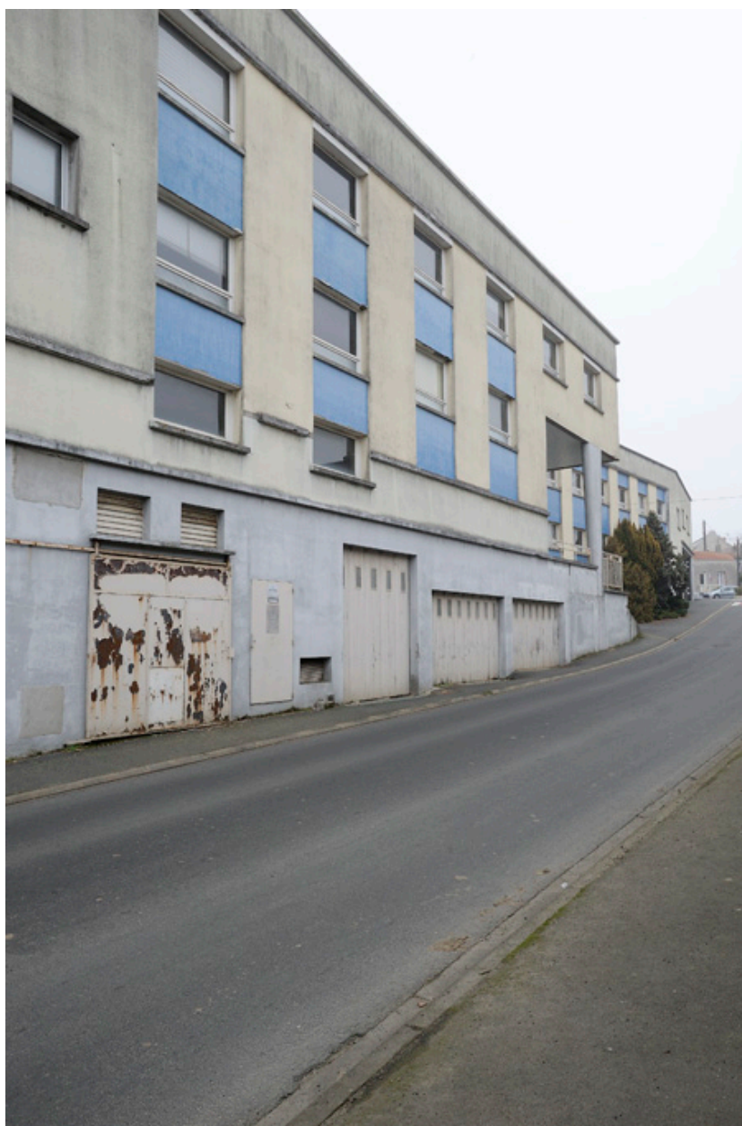
Usine Taïga (U1) façade rue Aigrefou.
