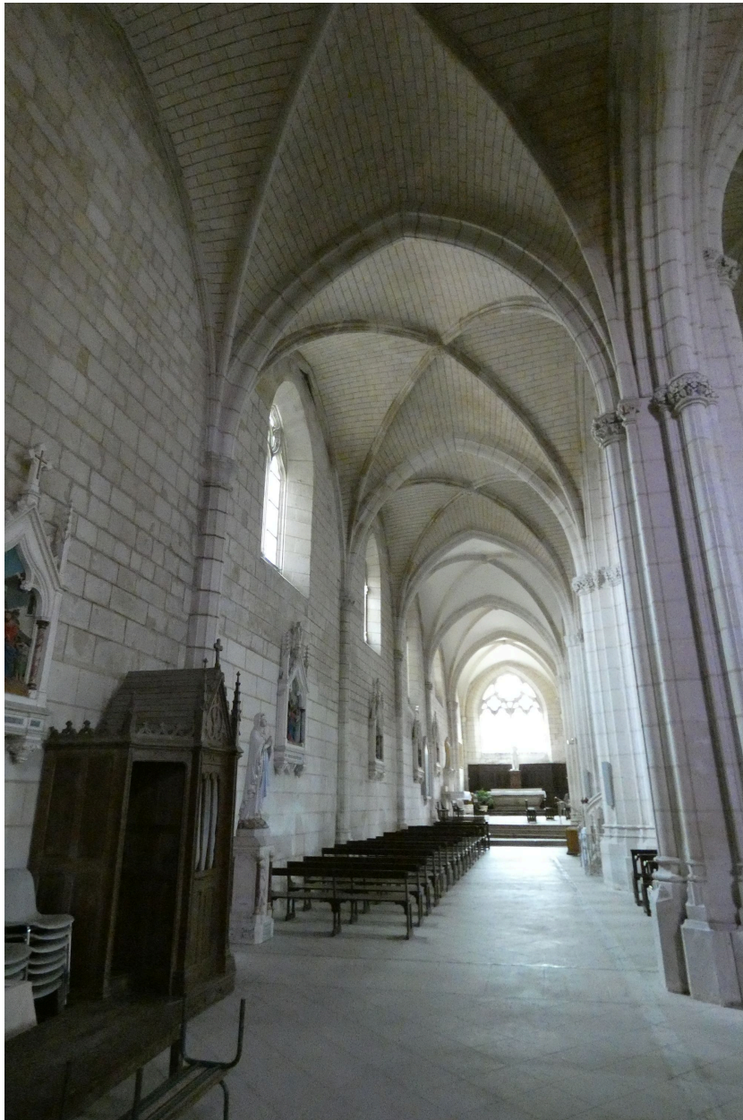
Le bas-côté nord vu depuis l'ouest.
