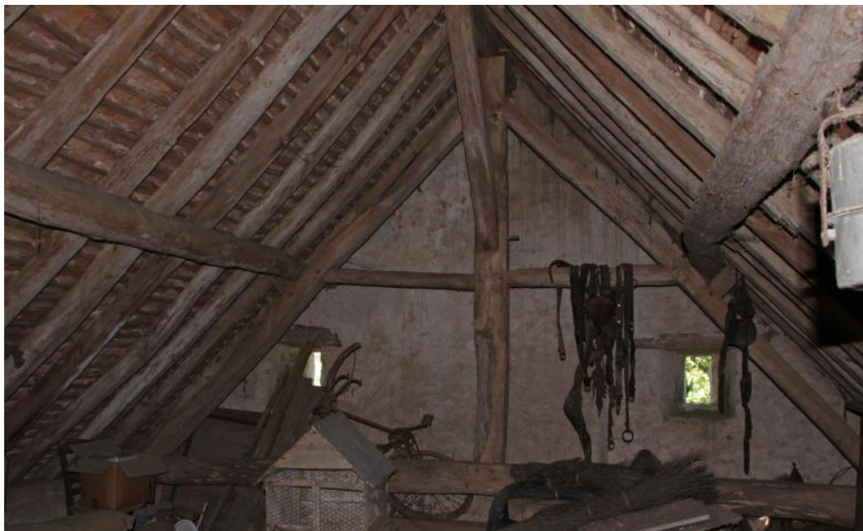
Maison 1 : charpente côté pignon ouest.
