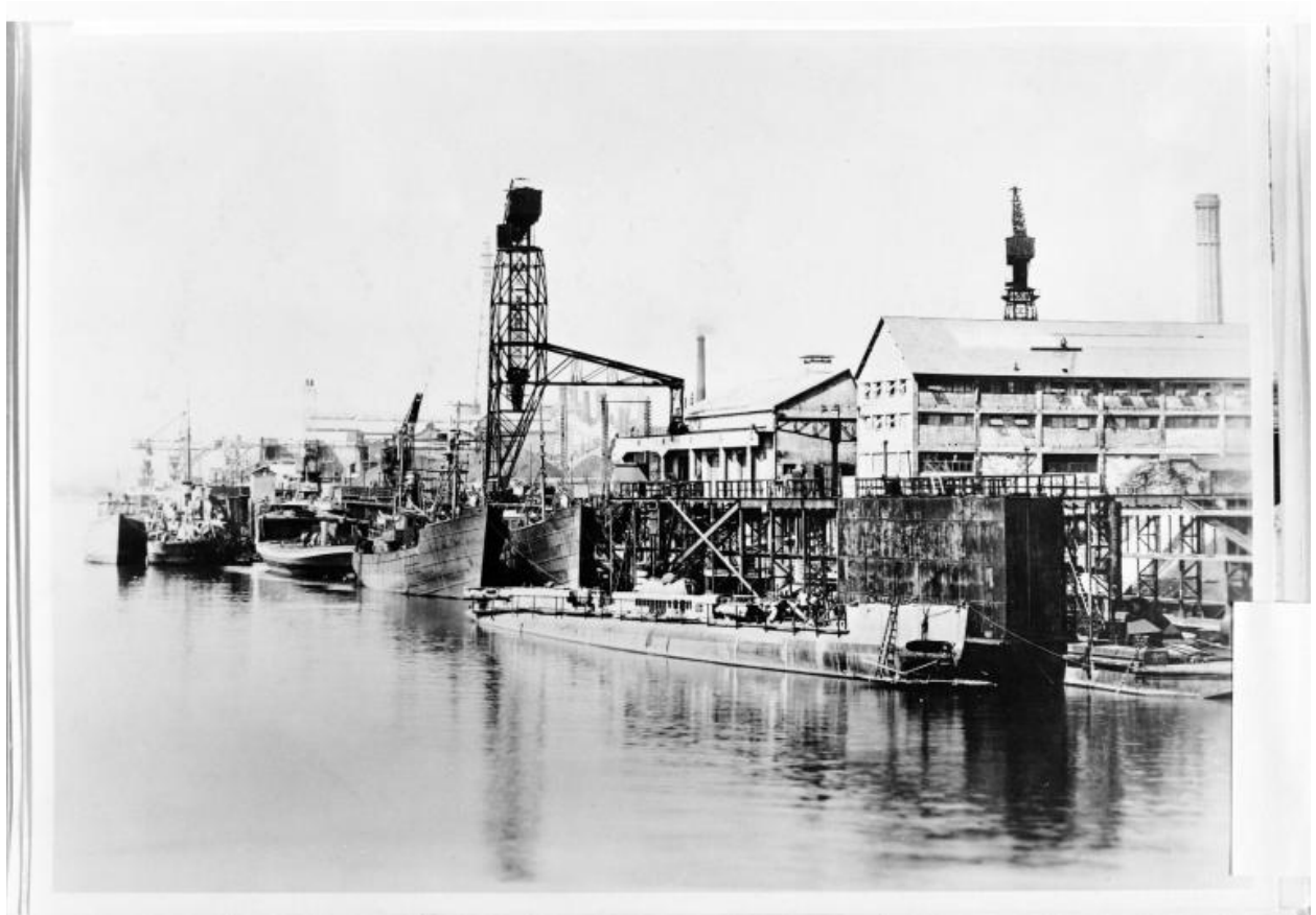
Grue et salle à tracer. (Association Histoire de la construction navale à Nantes).
