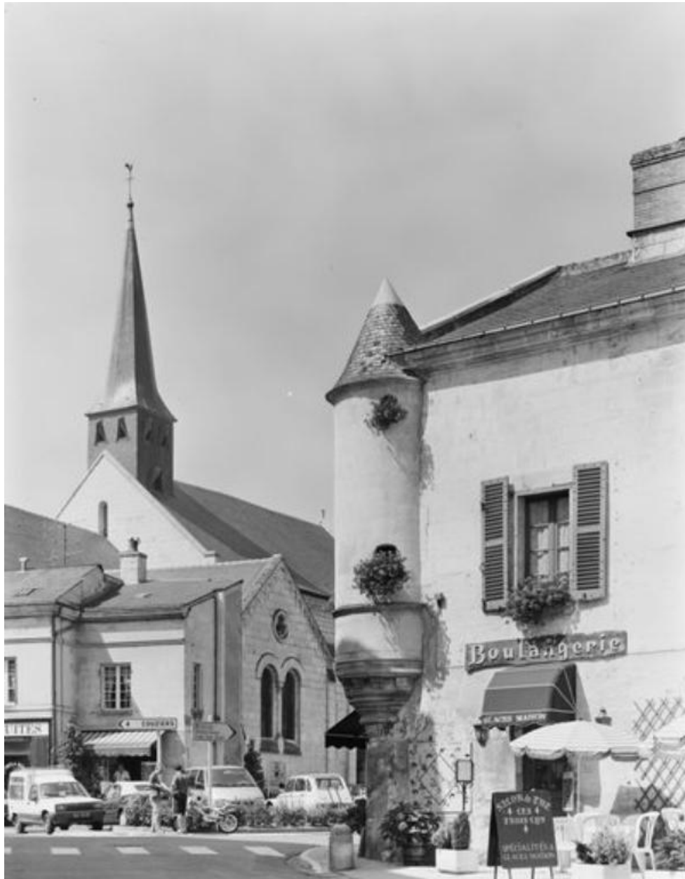
La place des Plantagenêts et l'angle de la maison, avant restauration (en 1994).
