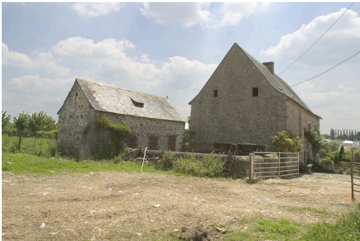
La porcherie et l'élévation latérale nord du logis.
