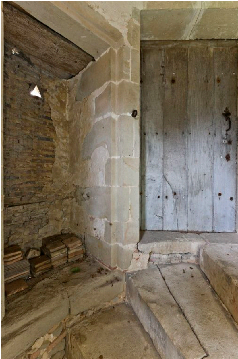
Latrine et porte d'accès à l'étage.
