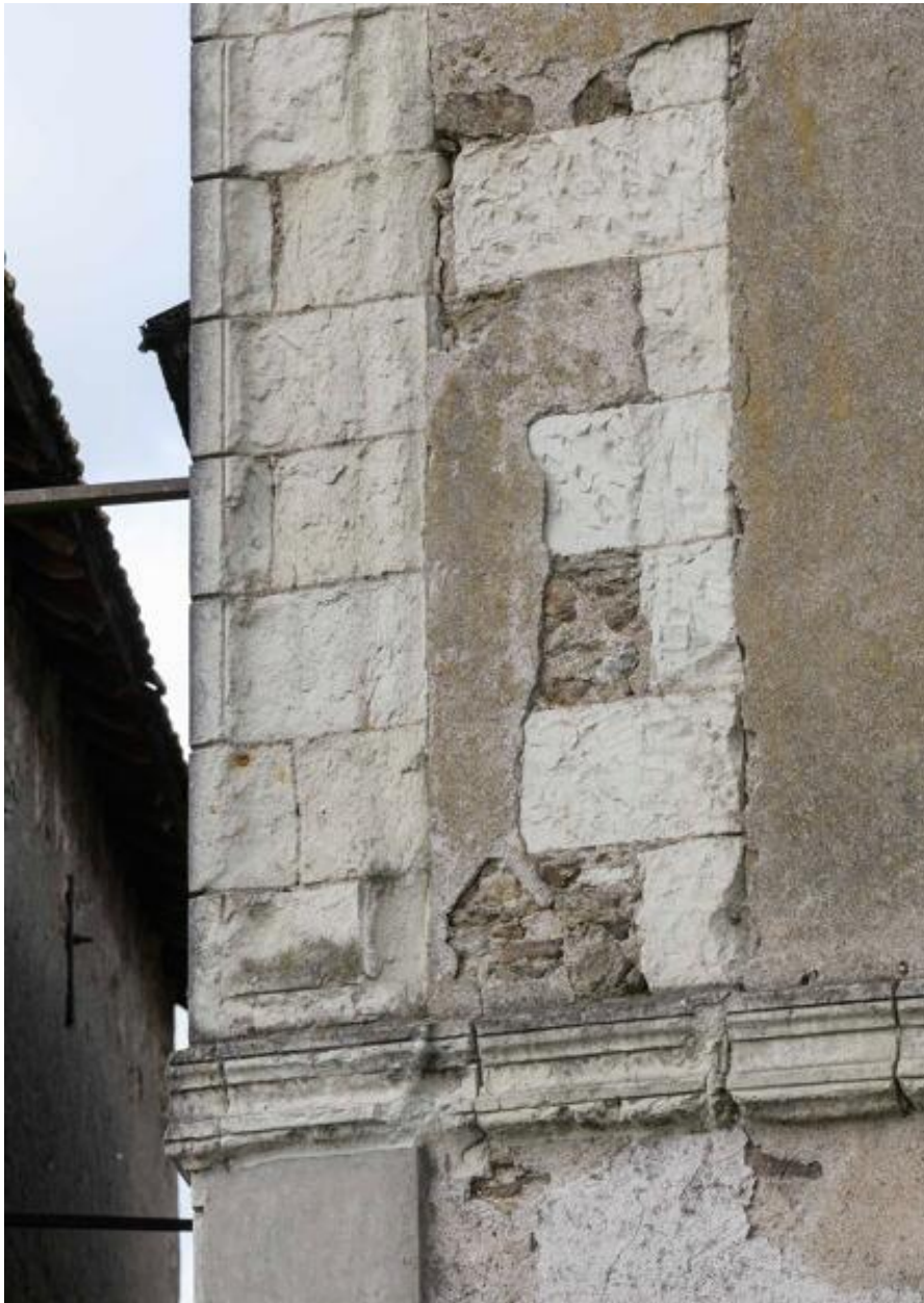
Détail d'un pilastre et d'une ancienne ouverture en pierre de taille de tuffeau.
