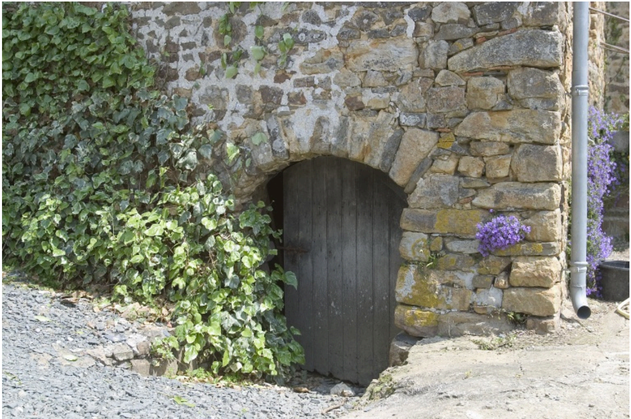
Le logis, élévation nord-ouest du pavillon : la porte d'accès à la cave.
