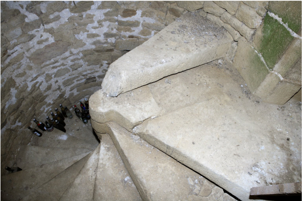
Logis. Tour d'escalier. Vue du dernier palier.
