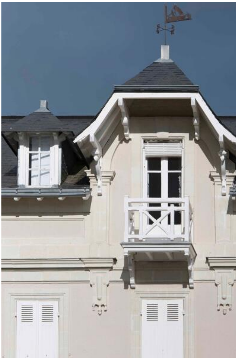
Vue de la façade est, détail.
