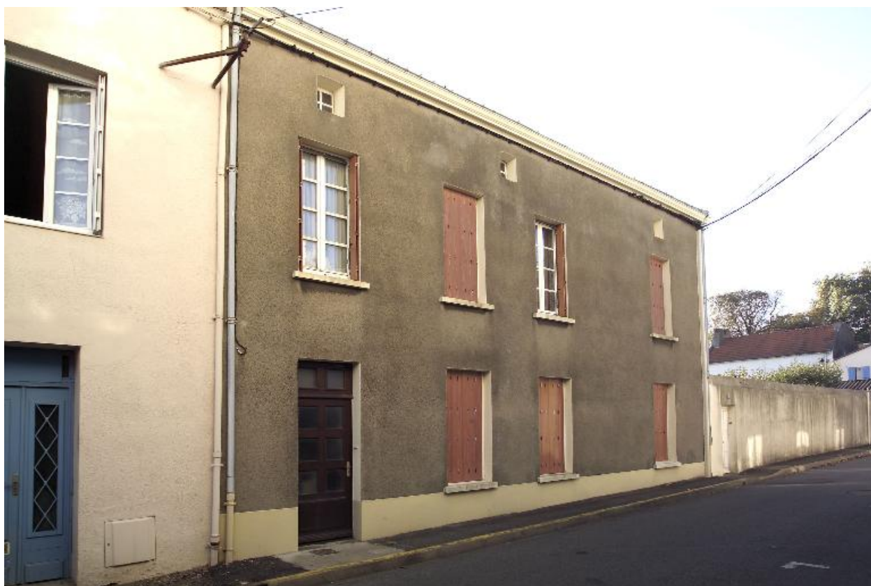
La façade antérieure de la maison n° 3 rue de l'Eglise.
