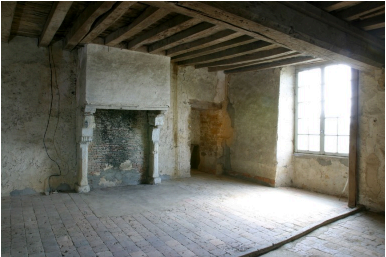
Rez-de-chaussée surélevé. La pièce 1B vue depuis l'angle sud-ouest.
