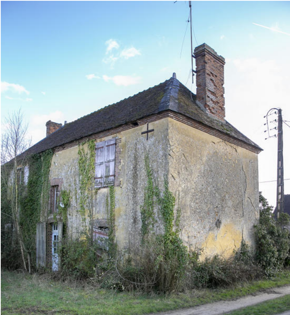
Le logement, façade sur cour.
