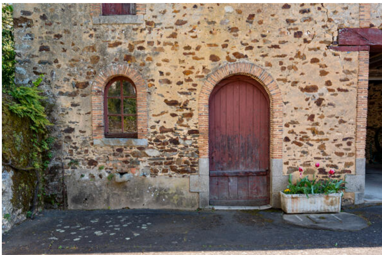
Les communs, détail du four.
