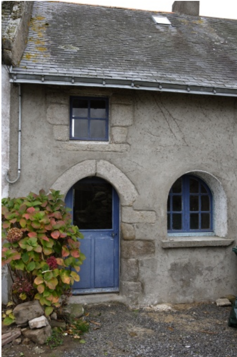
Vue du troisième logis (2 rue de la Riandouille).
