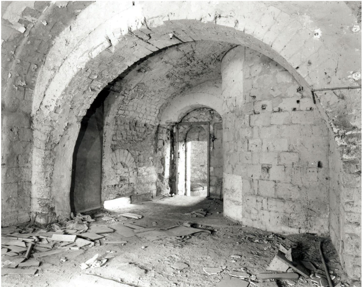
Collégiale Saint-Martin, collatéral sud du choeur : partie ouest ouvrant au fond sur le croisillon sud du transept. A droite, escalier du clocher.
