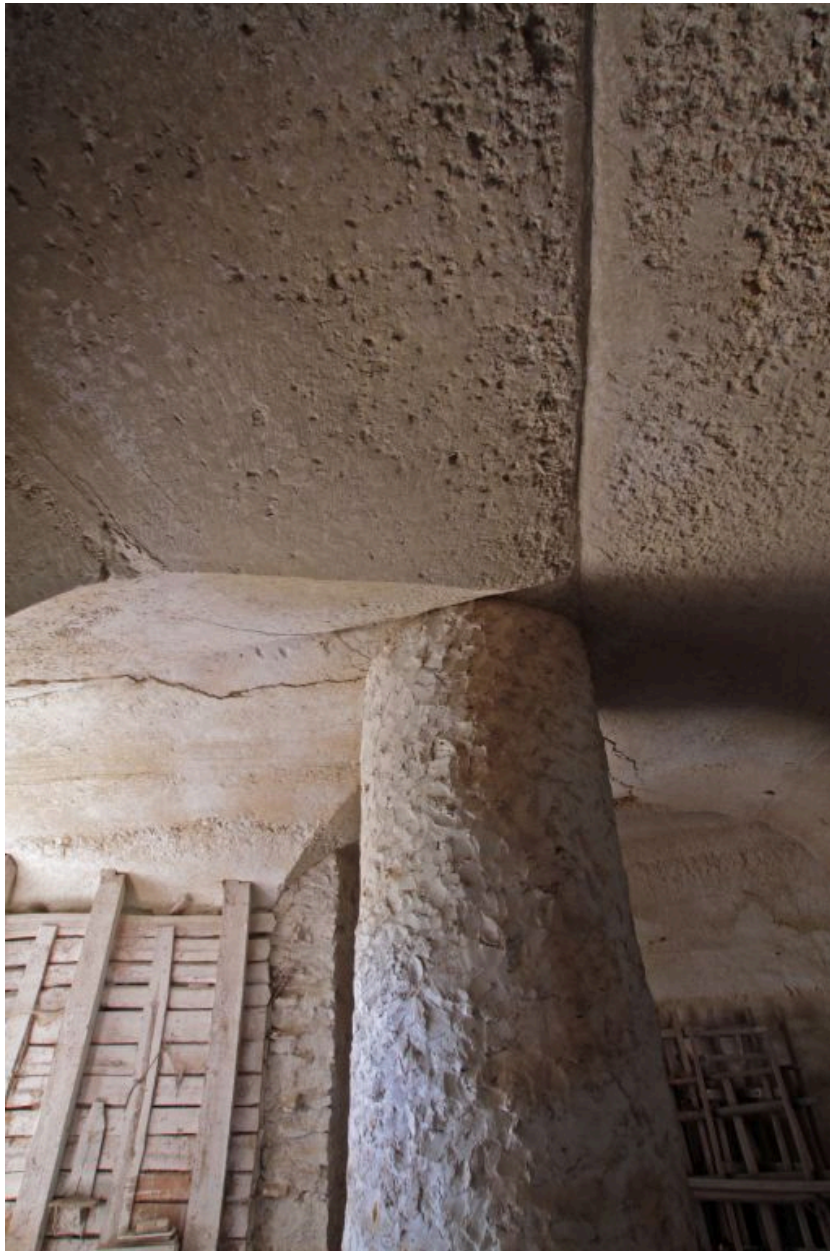
Pigeonnier, détail de la croisée des arêtes.
