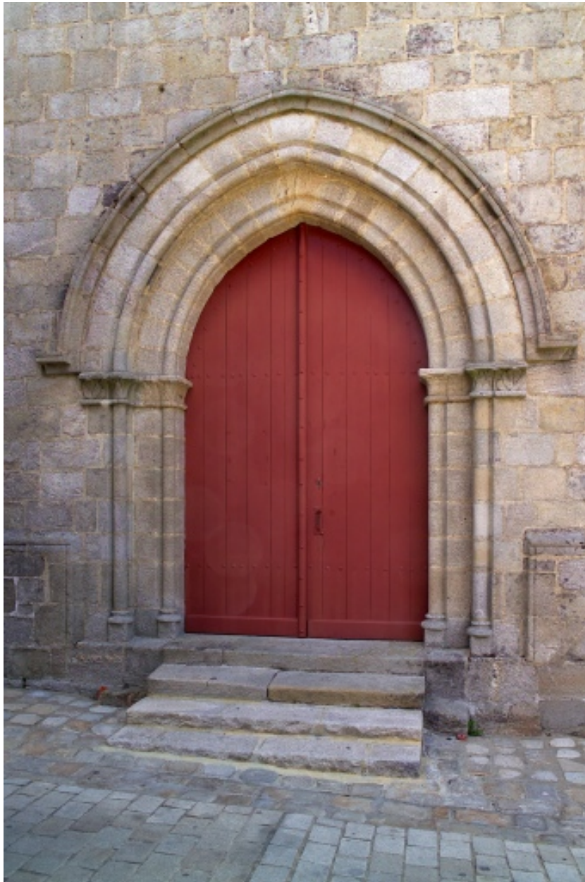
Détail du portail occidental.
