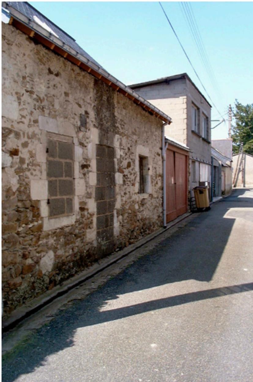
Maison en rez-de-chaussée avec vestiges de baies en tuffeau.
