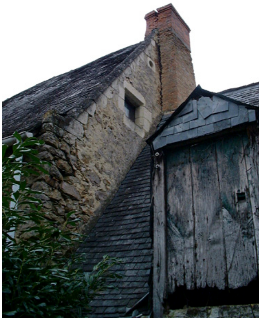
Vue du mur pignon est.
