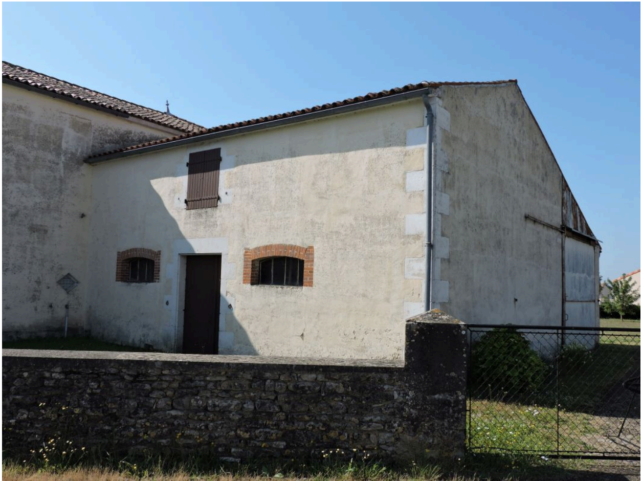
La grange-étable à l'arrière du logis, vue depuis le nord.
