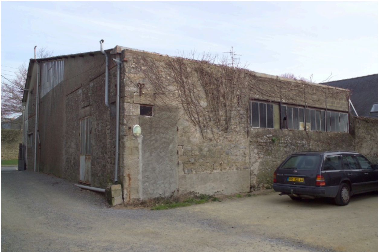
Ancien hangar de l'entreprise Guillouzo, façade postérieure.
