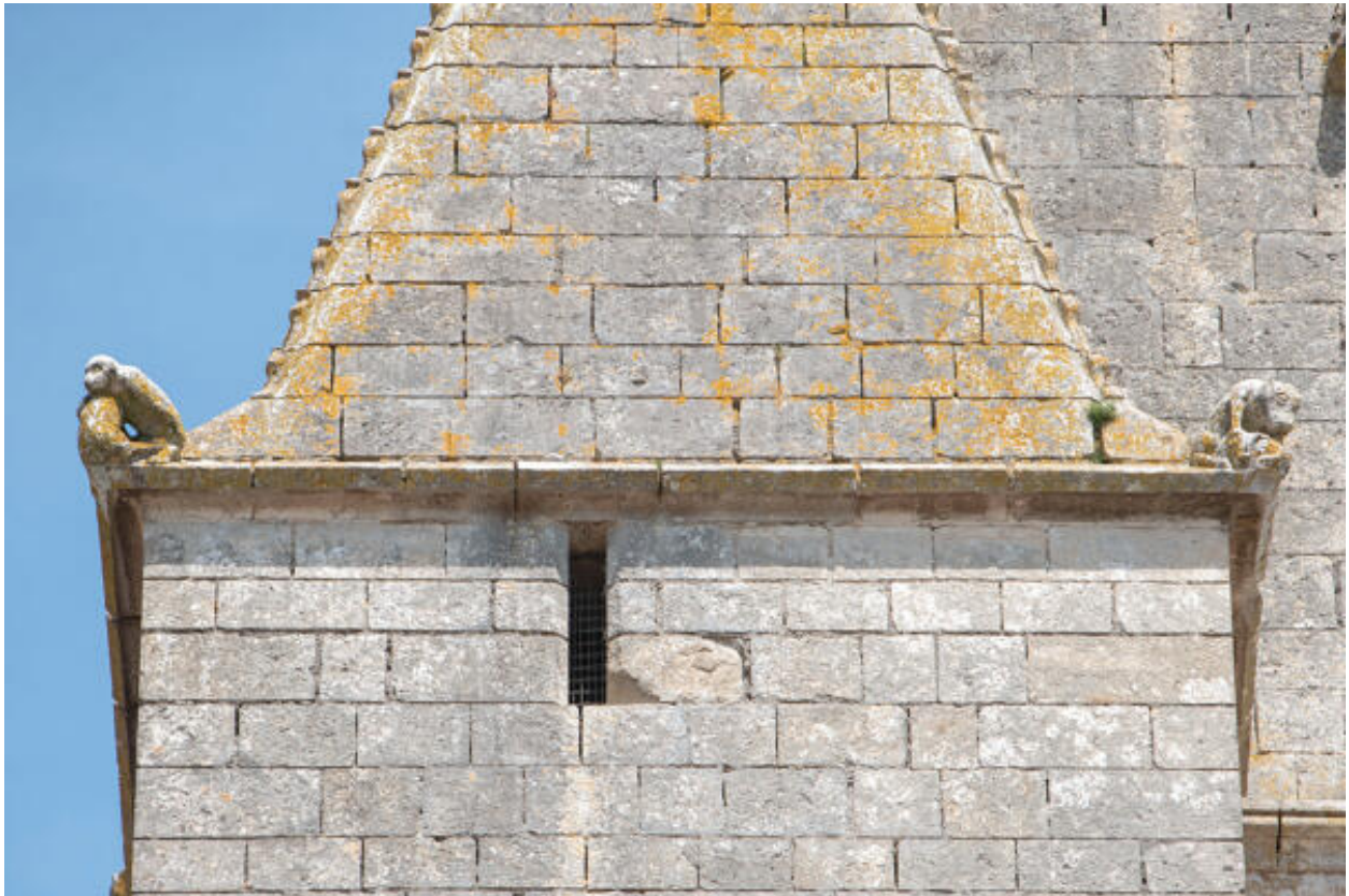
Maçonnerie et décor sculpté de la tour d'escalier du clocher, côté sud.
