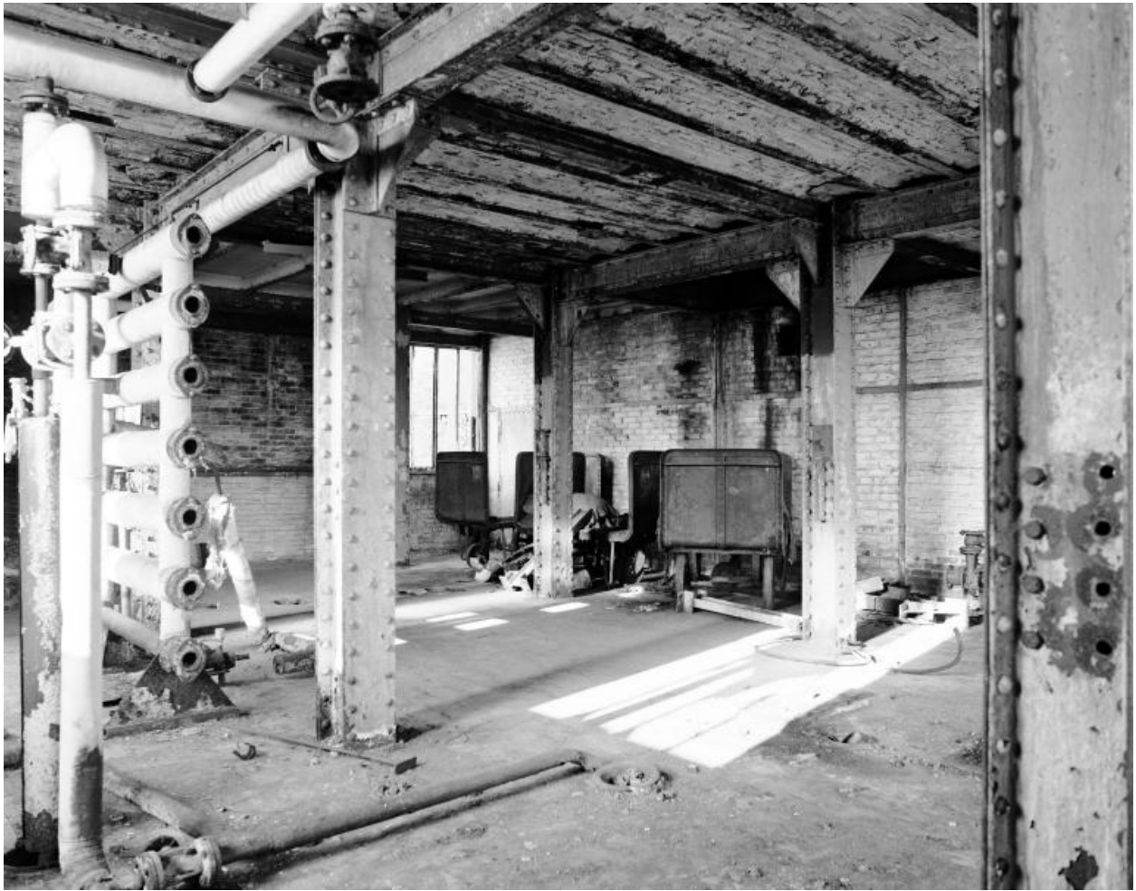
Nouvelle usine. Bâtiment non localisé. Atelier de décoloration sur résine. Vue d'ensemble.
