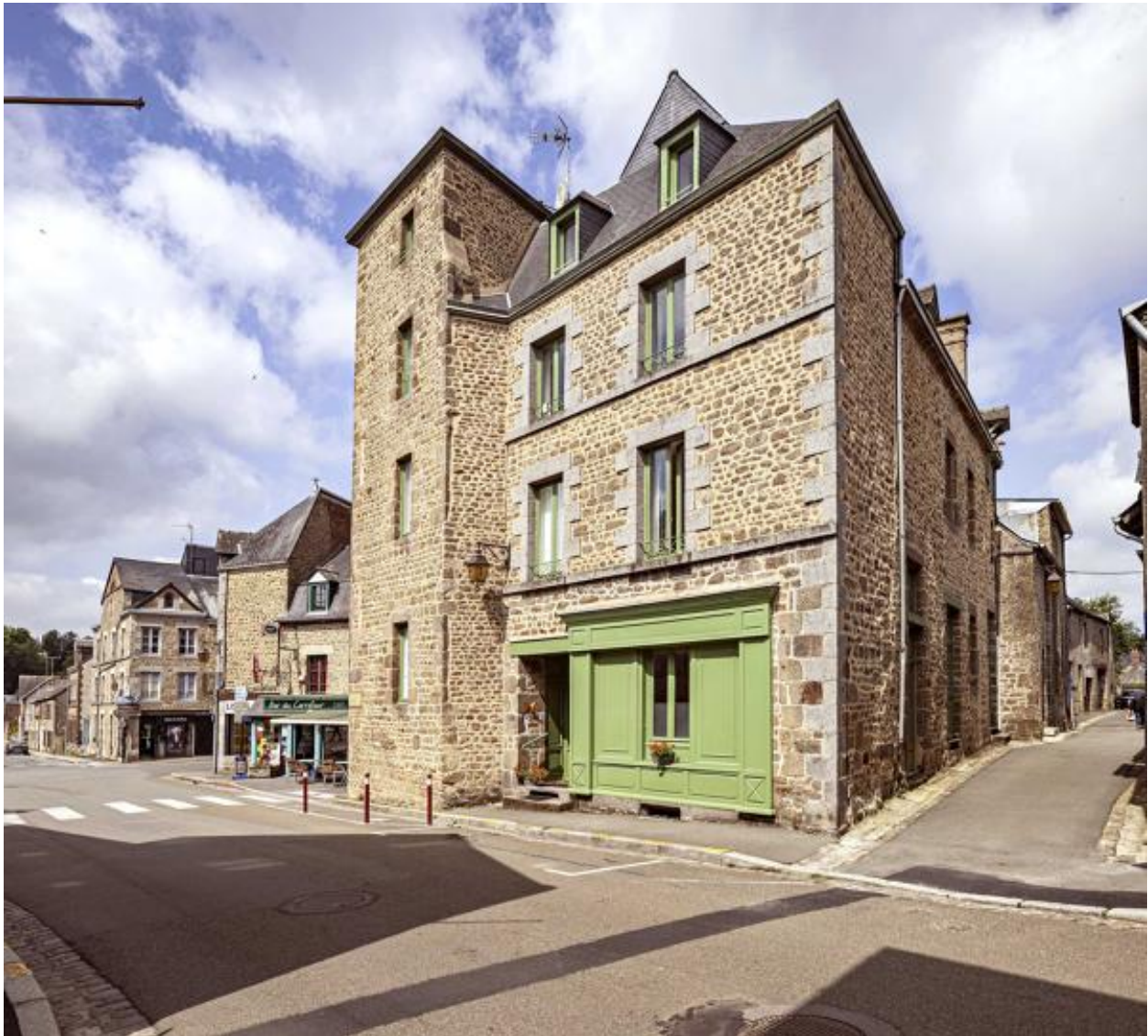
Ancien hôtel particulier, 31-33 rue Dorée. Façade latérale, refaite en 1837 lors du percement de la rue.
