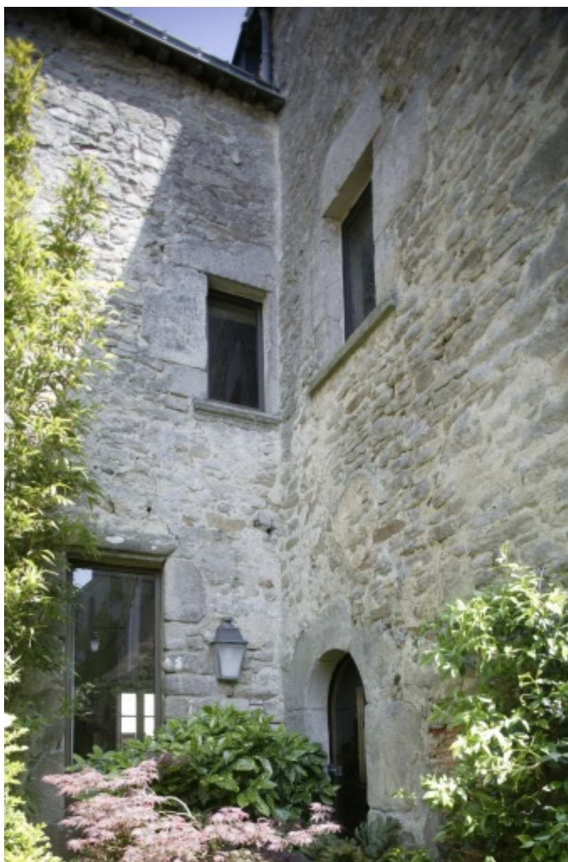
Façade postérieure et tour d'escalier, détail.
