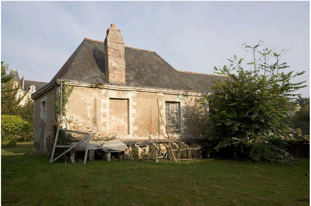
Maison dite maison du Souvenir : élévation postérieure depuis la basse-cour de la ferme.
