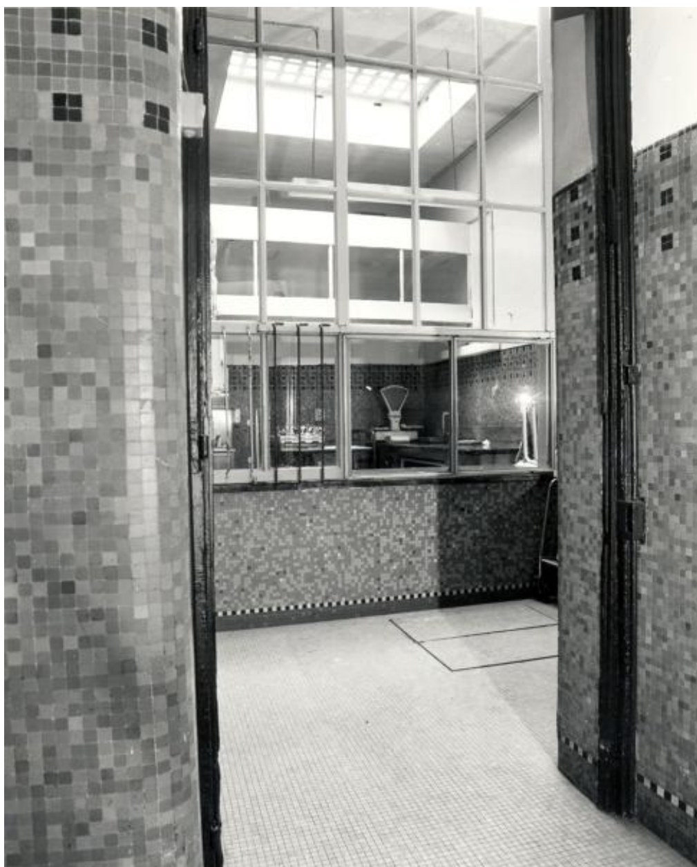
Bâtiment conventuel nord-ouest, extension moderne des cuisines sur la cour principale : vue intérieure.
