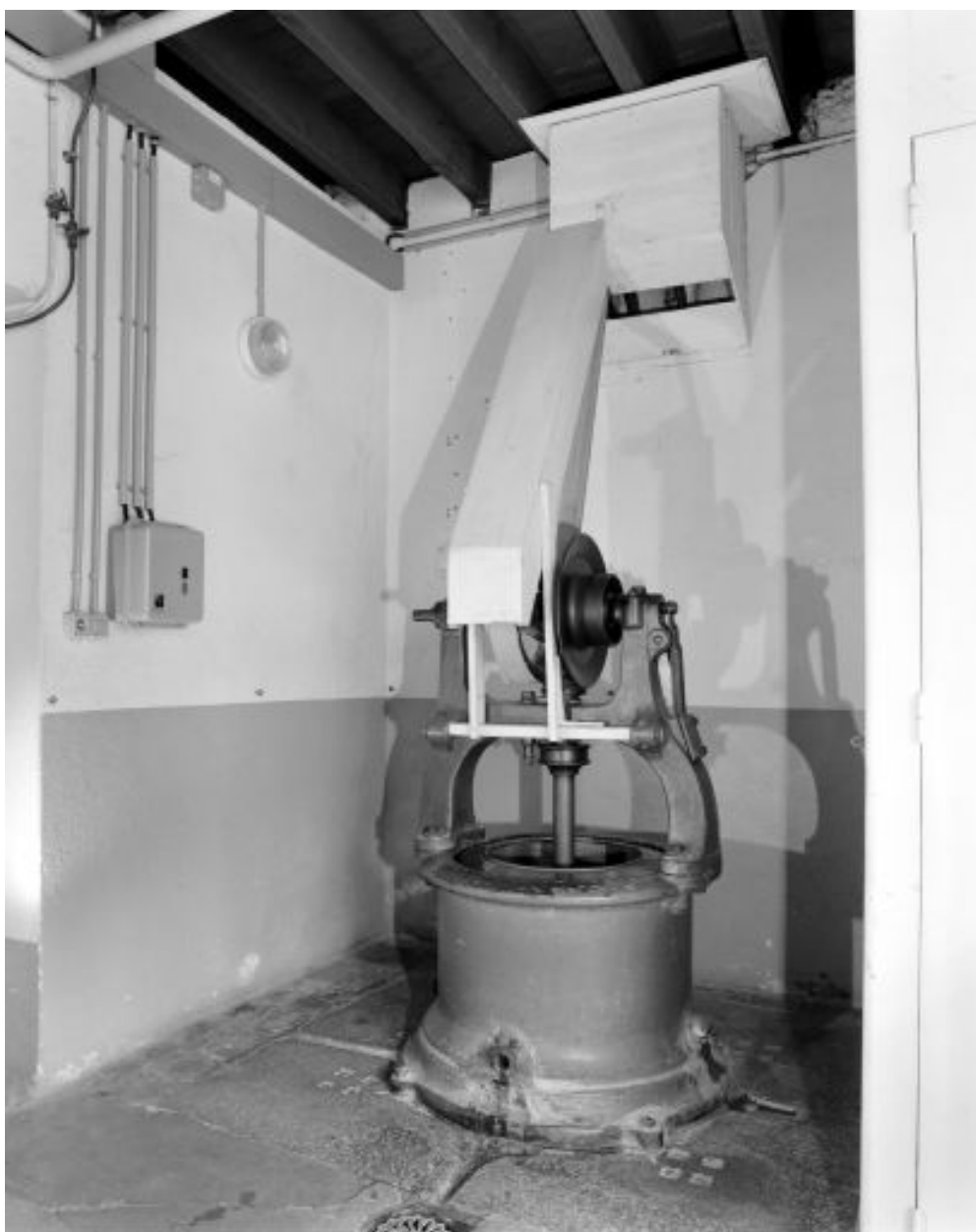
Buanderie, intérieur :essoreuse.
