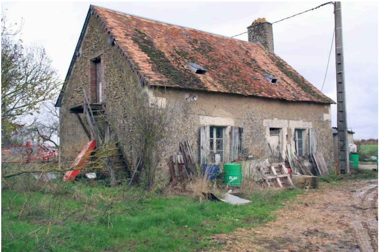
Maison 1, façade antérieure : surélévation de trois pierres.
