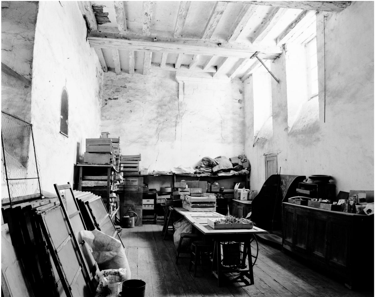
Bâtiment dit des lieux communs, rez-de-chaussée, pièce est : vue d'ensemble, d'ouest en est.
