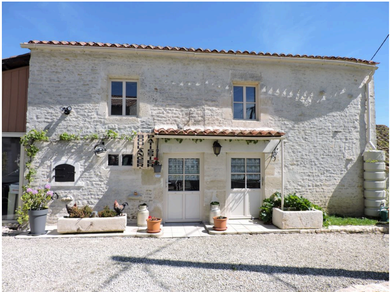
L'ancienne écurie-étable, au sud de la cour, vue depuis le nord-ouest.
