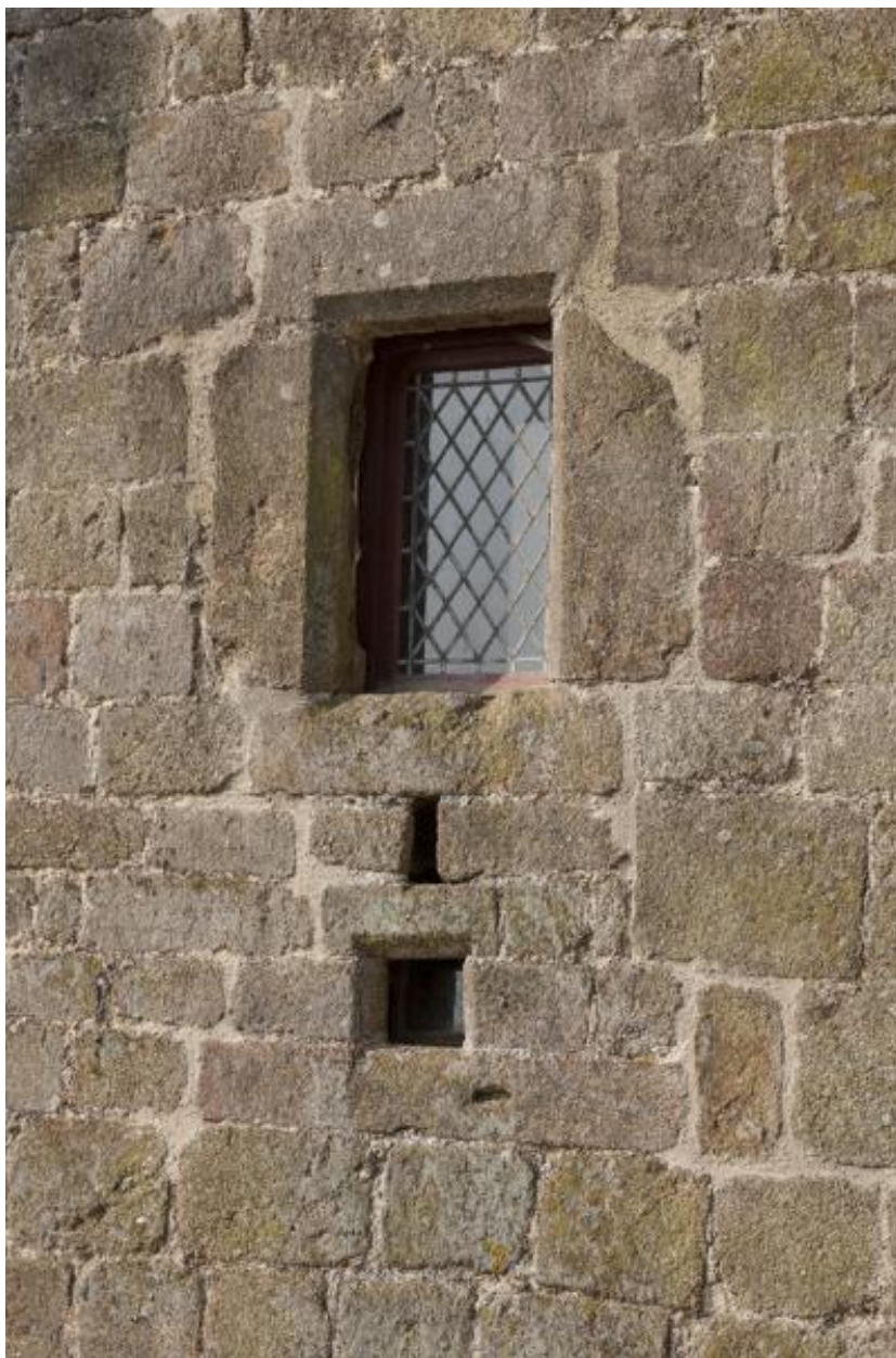
Ouvertures de la tour orientale du châtelet.
