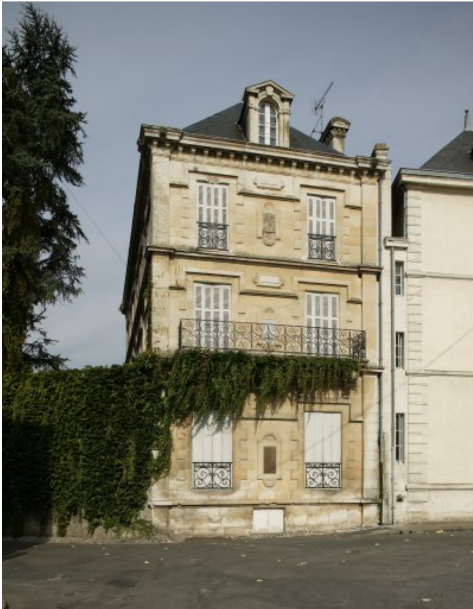
Façade latérale, place Leclerc, de la maison 2, rue Millesouris, construite en 1871 pour Anatole de la Bauduère.
