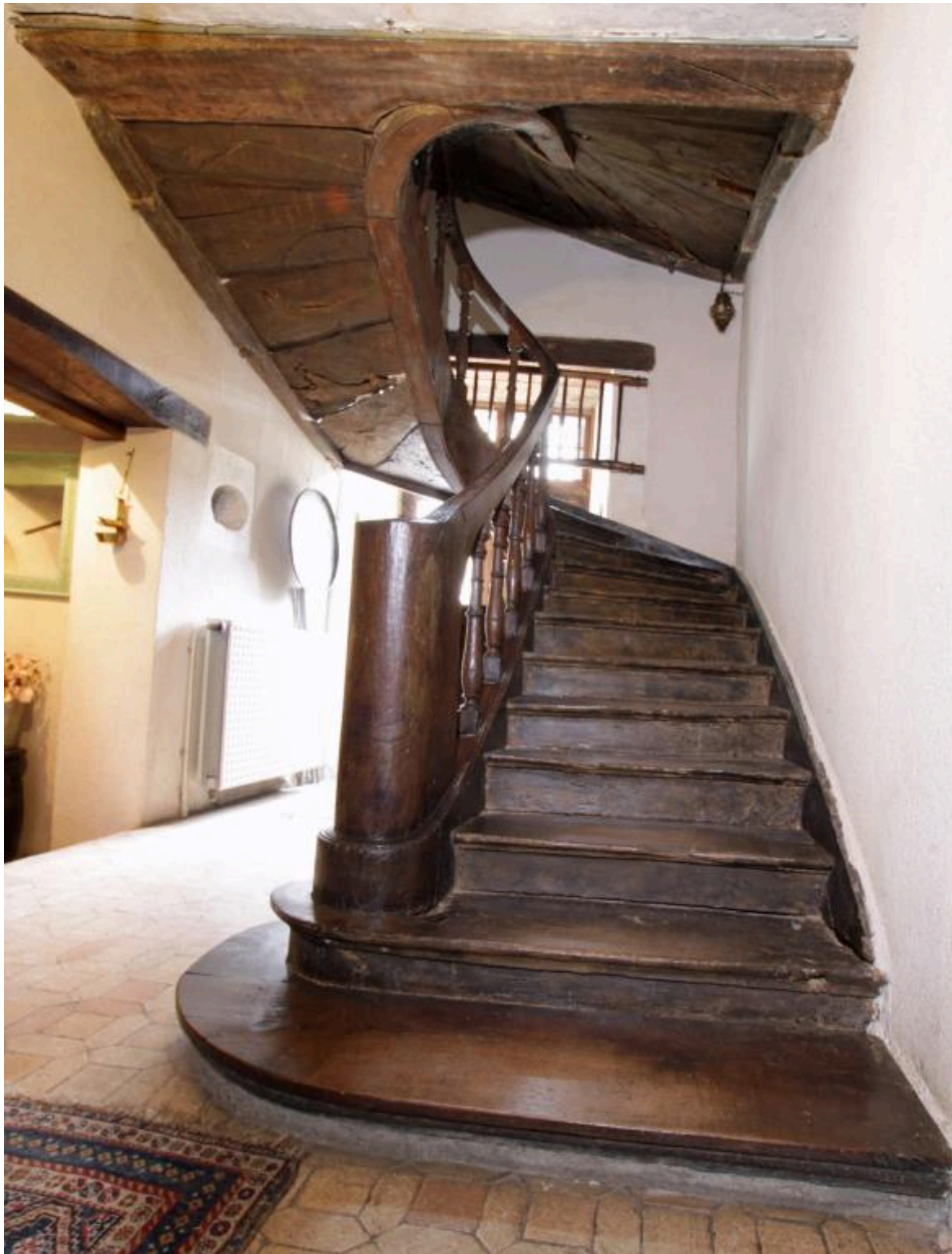
Logis, rez-de-chaussée, corridor : escalier tournant en bois.
